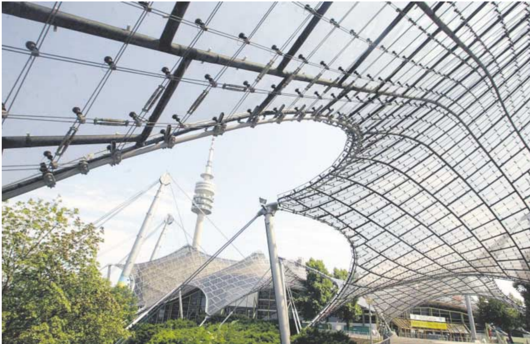
Das weitgespannte gläserne Seilnetzdach ist nicht nur zum Erkennungszeichen des Münchner Olympiastadions geworden, es hat auch Ingenieurgeschichte geschrieben
